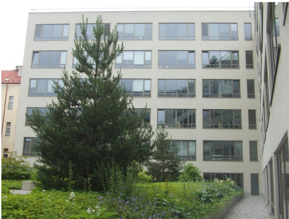
Obr. 2 – střešní zahrada administrativní budovy nad obchodní pasáží
