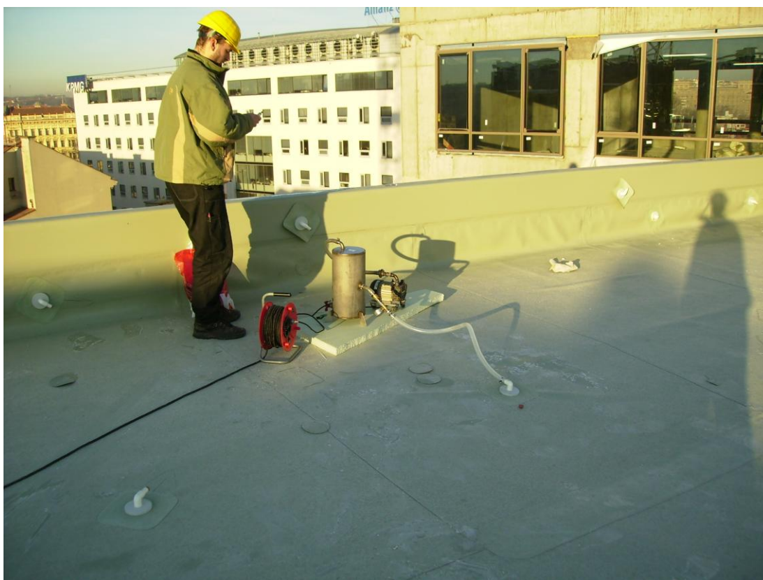
Obr. 4 – střecha administrativní budovy nad kanceláři středního traktu – pracovník provádí plošnou objektivní podtlakovou kontrolu hlavní hydroizolace z dvojitého sektorovaného fóliového systému před zakrytím provozním souvrstvím
