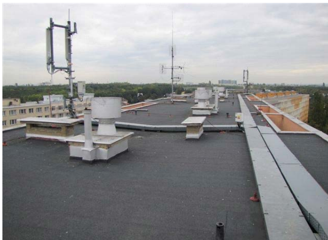
Pohled na střechu
