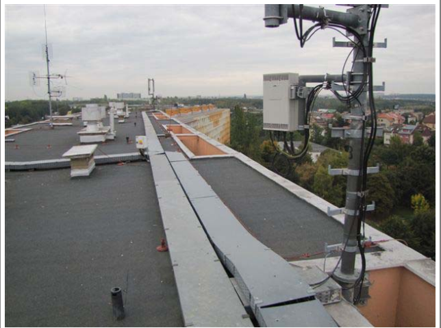
Pohled na střechu
