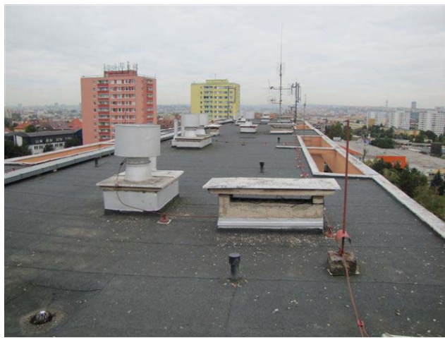
Pohled na střechu
