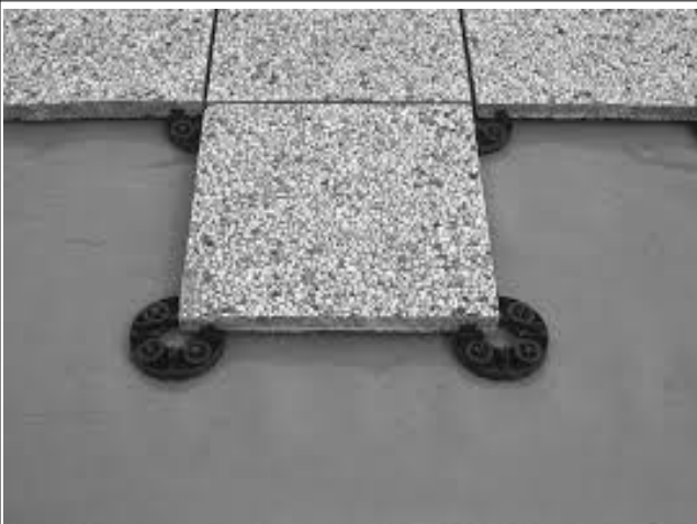
Dlažba na podložkách
