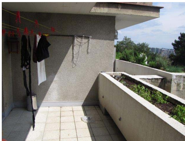
Pohled na terasu
