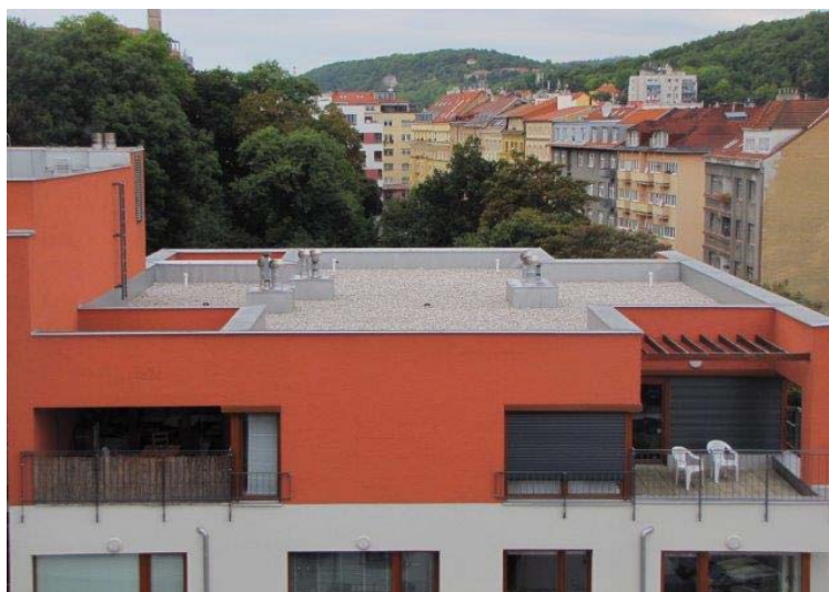
Pohled na střechu
