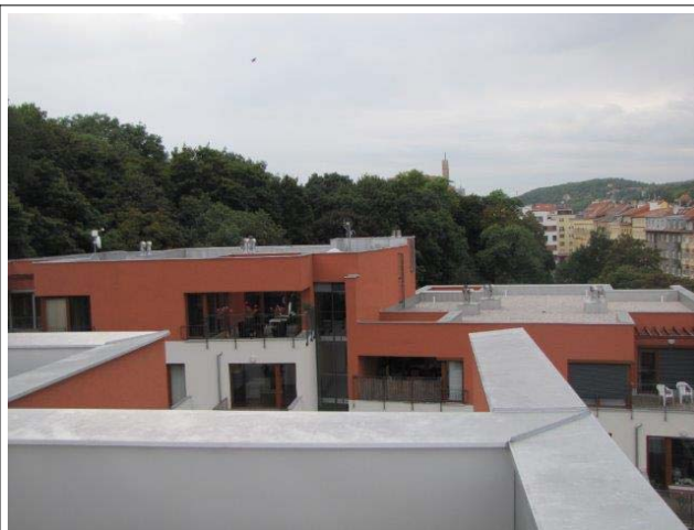
Pohled na střechu
