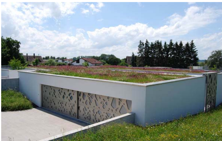
Pohled na střechu
